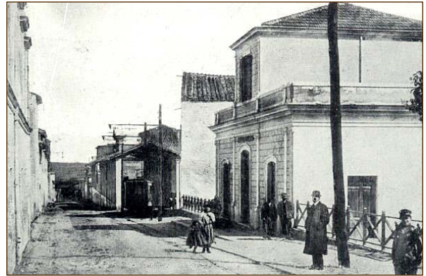
Stazione tramviaria a Civita Castellana.
