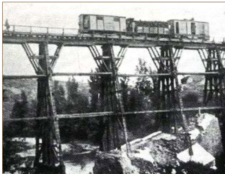
Ponte provvisorio in legno sul Treja.
